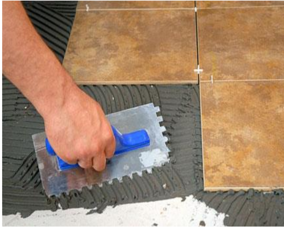
Bancuhan simen digunakan bagi pemasangan jubin lantai seramik.
