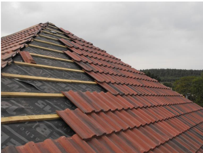
Pemasangan Roof Tile
