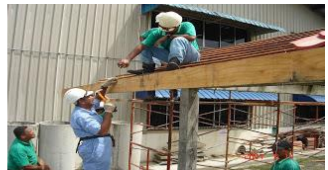
Pemasangan Tumpu Kasau/Papan Muka (Facia Board)
