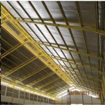
Kerja-kerja pemasangan Kasau (rafter) untuk Kekuda Bumbung (roof trusses)
