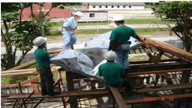
Pemasangan Aluminium Foil
