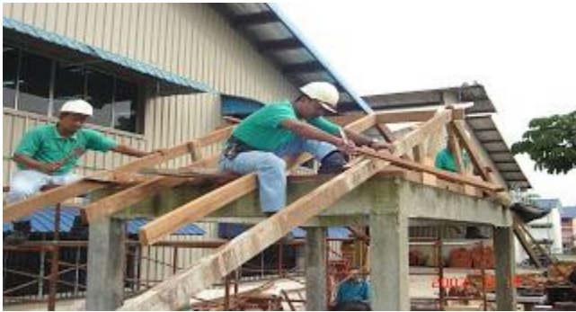
Kerja-kerja pemasangan Kasau (rafter) untuk Kekuda Bumbung (roof trusses)
