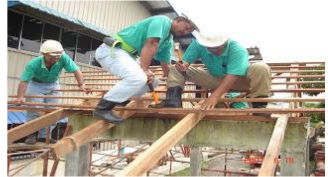
Pemasangan kayu beroti (batten) untuk kerangka Bumbung
