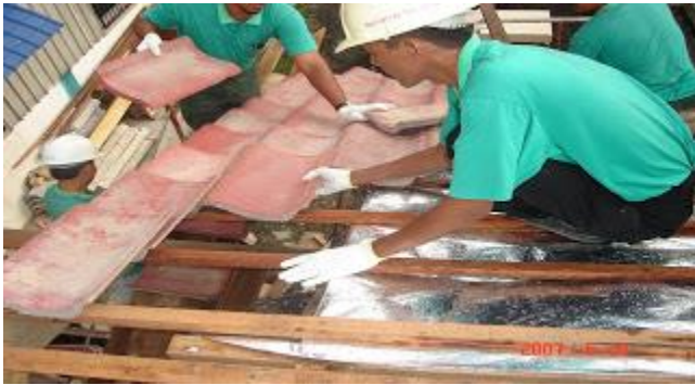
Pemasangan Roof Tile
